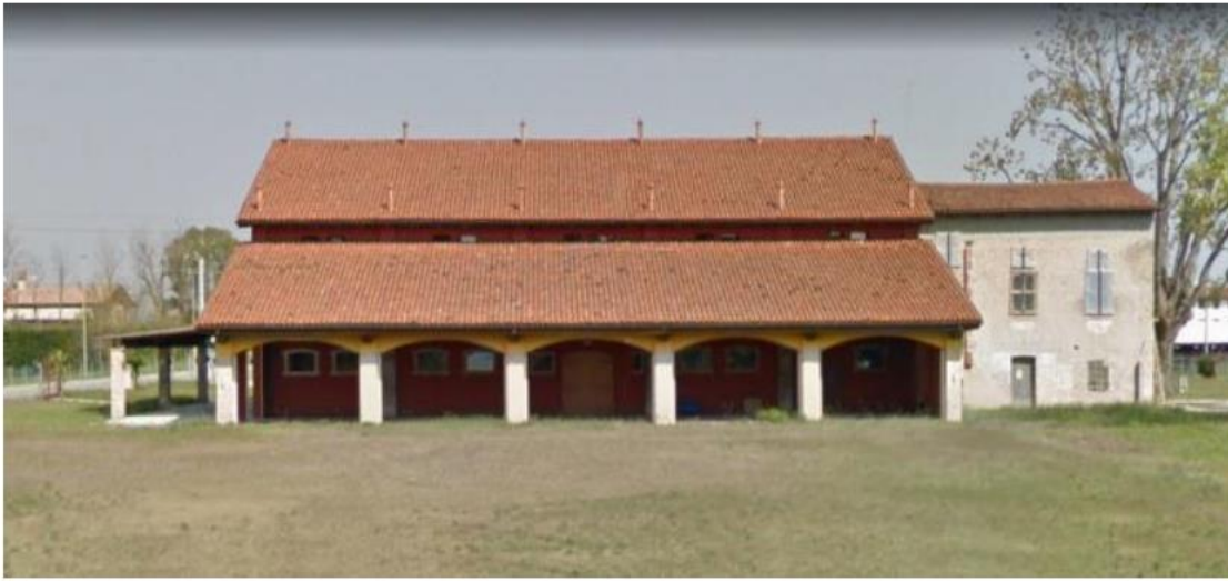
Prospetto Laterale Via Fausta
