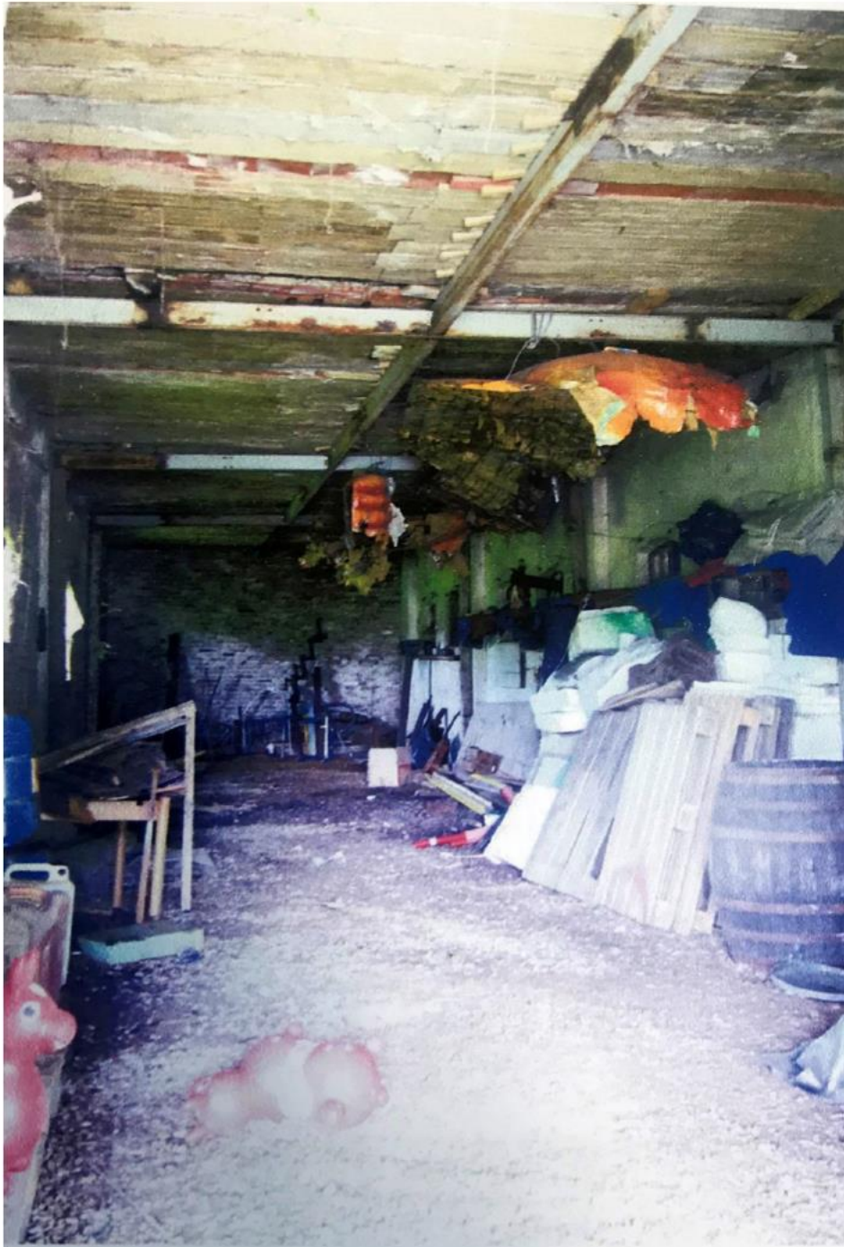
Foto n° 19 - Interno con evidenti elementi metallici a supporto del tetto piano
