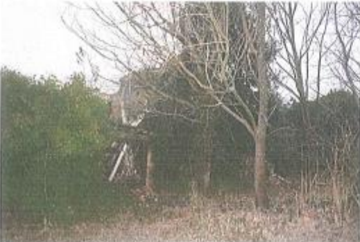
Vista interna (Nord-est)
